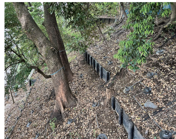
【取組②】斜面对策工事写真
