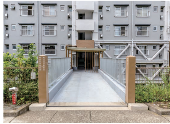
修繕したエントランスとブリッジ
