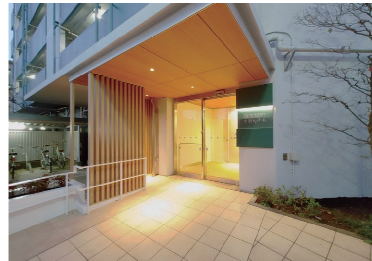
エントランス改修
