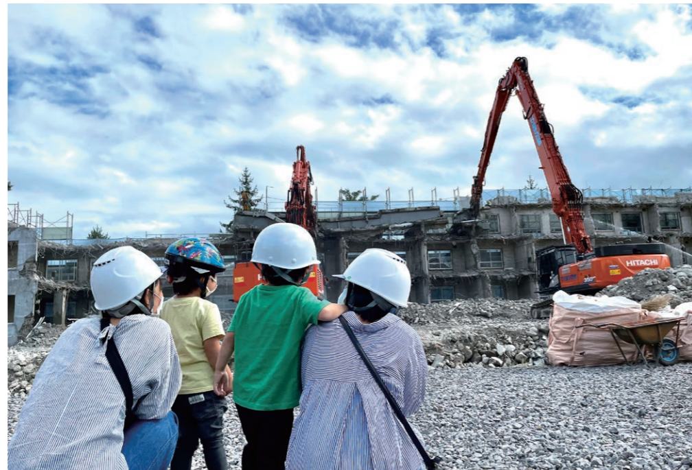
迫力満点の解体作業に興味津々
