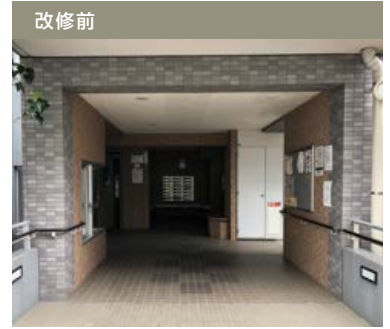
改修前 奥が暗い日中のエントランス
