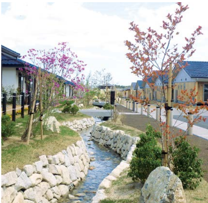
災害公営住宅
