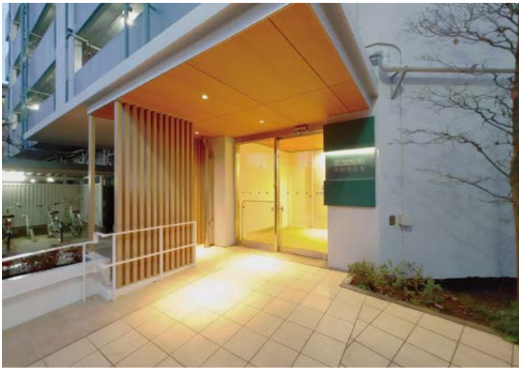
エントランス改修
