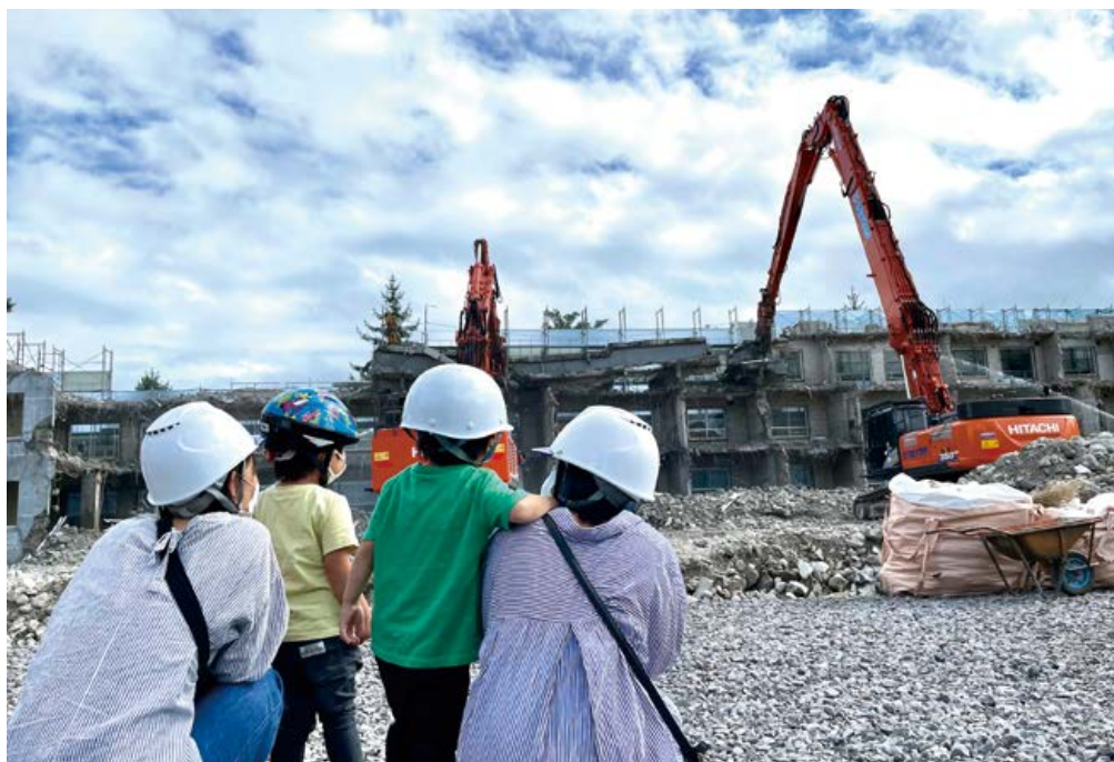
迫力満点の解体作業に興味津々
