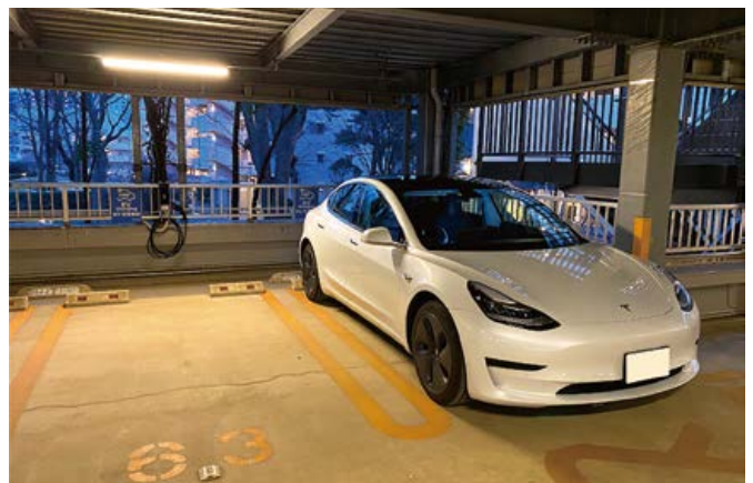
EV充電設備付き駐車場
