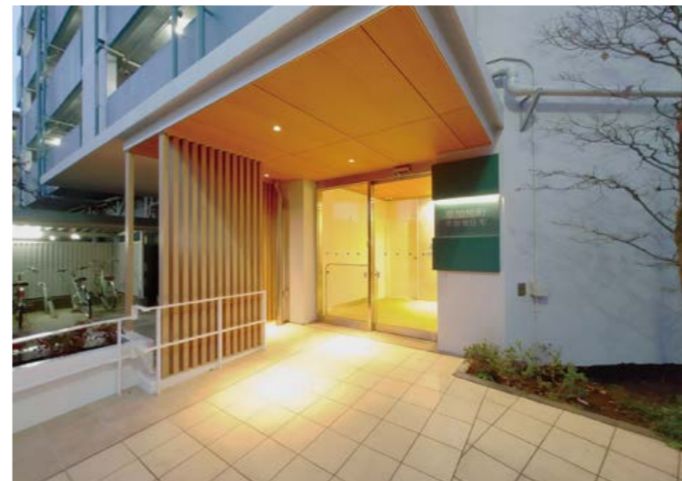
エントランス改修
