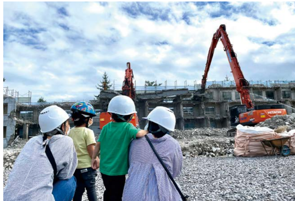
迫力満点の解体作業に興味津々
