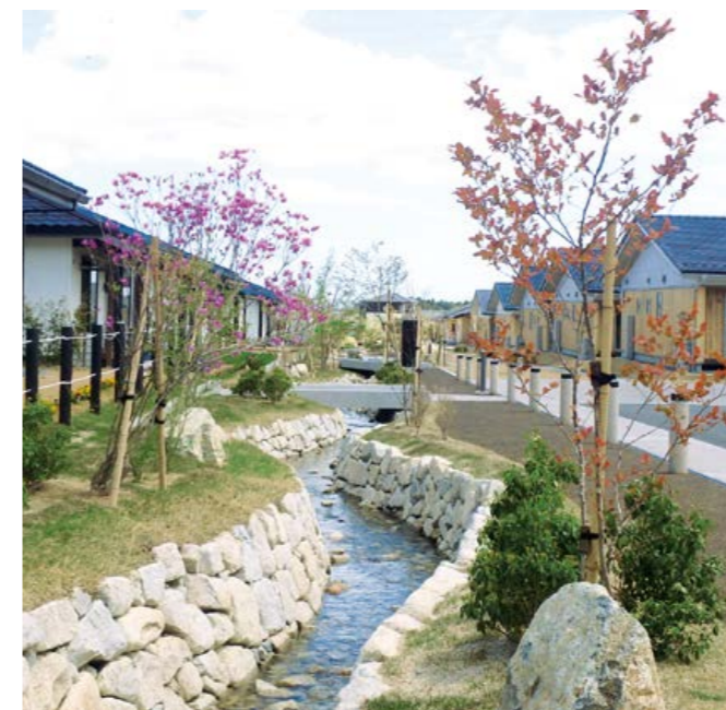
災害公営住宅
