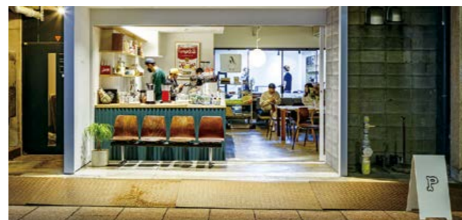
問屋ビルの改修による物件活用 (MIDORI.so BAKUROYOYOKOYAMA)
