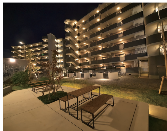
アーバンラフレ虹ヶ丘東（愛知県名古屋市中東区）
