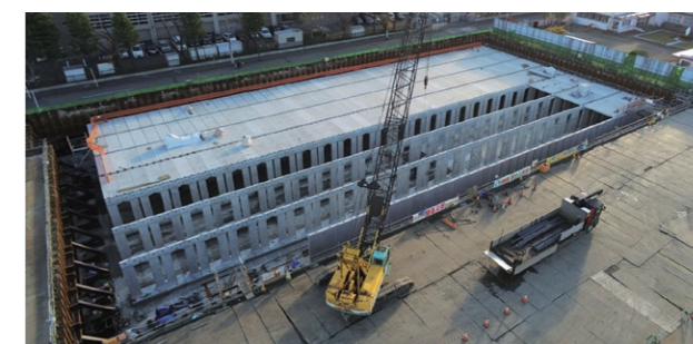
貯留槽躯体施工状況
