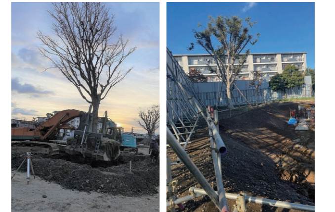
特殊重機による移植(浜見平団地)
