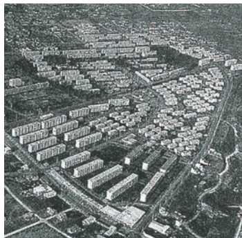
宅地分譲始まる(多摩平地区:東京都日野市)
