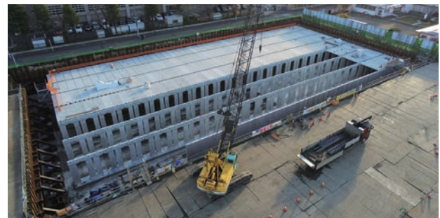
貯留槽躯体施工状況
