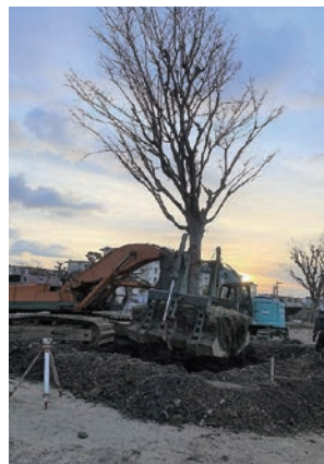
特殊重機による移植（浜見平団地）
