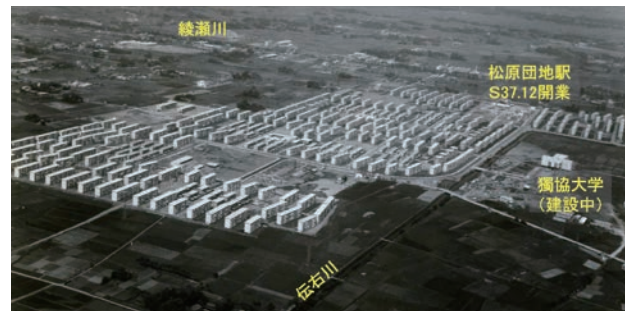
団地建設当時の状況（1962年頃）
