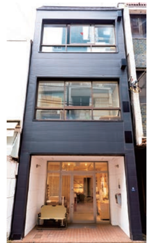
UR都市機構が買い支えし、事業者が改修を行った建物
