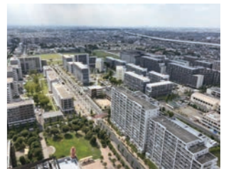
建替後団地全景
