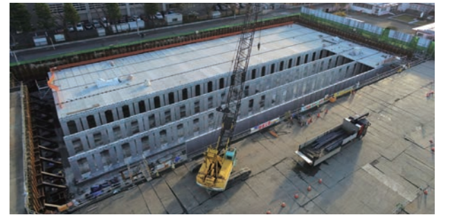
貯留槽躯体施工状況
