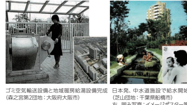
ゴミ空気輸送設備と地域暖房給湯設備完成(森之宮第2団地:大阪府大阪市) 日本発、中水道施設で給水開始(芝山団地:千葉県船橋市) 右: 囲み写真: イメージポスター第1号
