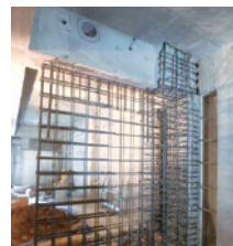
1階柱を増打ち、壁増設により補強
