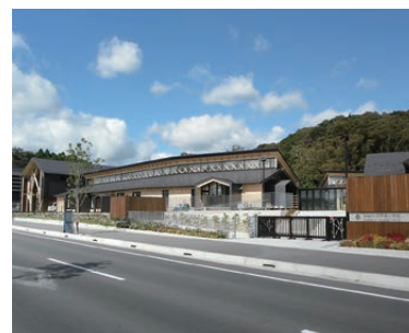
東松島市立宮野森小学校は意匠を凝らした木造建築
