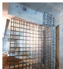
1階柱を増打ち、壁増設により補強
