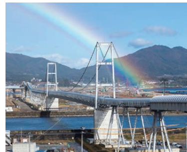
総延長約3kmに及ぶベルトコンベア
