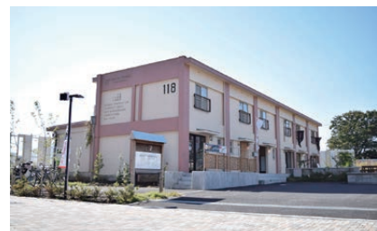
既存テラスハウスを活用したひばりテラス 118
