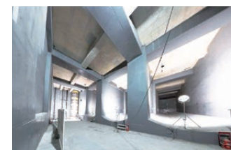
渋谷駅東口雨水地下貯留槽の内部
