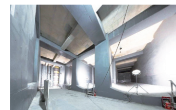
渋谷駅東口雨水地下貯留槽の内部
