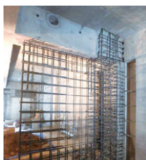
1階柱を増打ち、壁増設により補強
