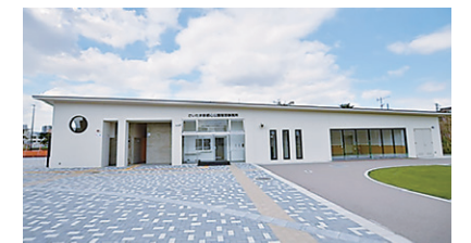
災害時には避難支援の拠点となる管理棟
