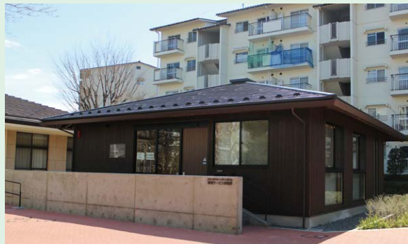
かわつるグリーンタウン松ヶ丘 管理サービス事務所 外観
