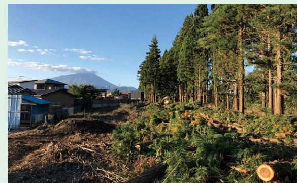
従前の鉄道防雪林を全数伐採（写真は伐採状況）
