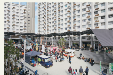
敷地の高低差を生かした2階デッキや、開放的で爽やかな緑側空間が特徴の中央広場
