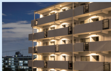
LED照明の採用で消費電力の低減を図り、 発電に伴うCO 2 発生量削減に寄与
