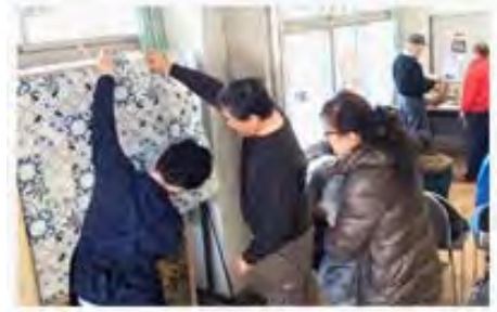
キッチンのリメイクシート貼り
