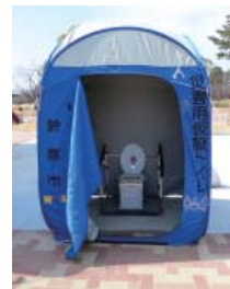
災害用マンホールトイレ
