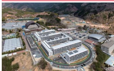
女川町営運動公園住宅（宮城県女川町） 撮影者：沖 裕之（Blue Hours）
