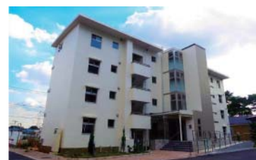
サービス付き高齢者向け住宅 (既存住棟大規模改修)
