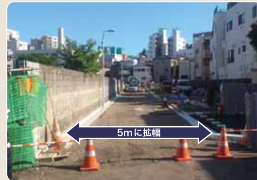
現況（道路拡幅工事の様子）
