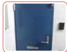
3 玄関扉の交換による断熱性・防音性の向上
