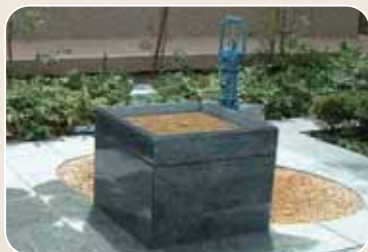
手押しポンプ（雨水利用）
