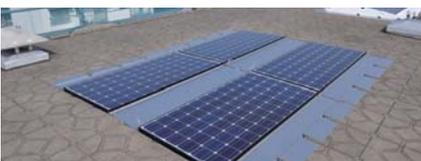
工法3 コンクリートブロックをSUSパネルに置き換え、その上に樹脂製軽量架台を設置
