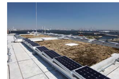
建物屋上の太陽光発電(シャレール海岸通)
