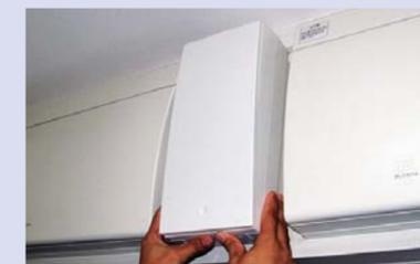
分電盤横にセンサーを設置
