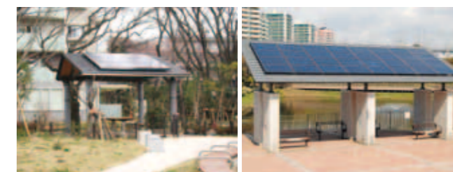
あずまや屋根に設置された太陽光発電設備
