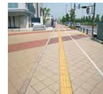
透水性舗装 (三郷中央 / 埼玉県三郷市)
