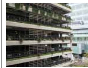
駐車場の壁面緑化 A
