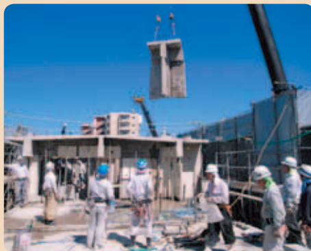
減築（耐力壁の撤去）（左） 減築（屋根スラブの撤去）（右）
