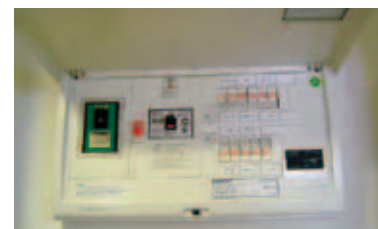
上) 音声警報の感想 左) ピークアラーム機能付分電盤
