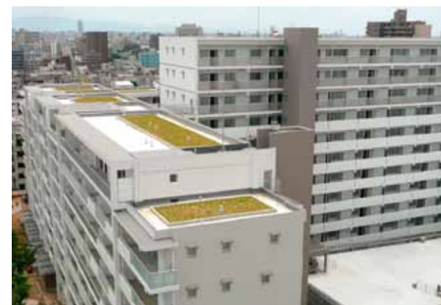
屋上緑化（サンヴァリエあべの阪南/大阪市）平成22年3月頃の様子
