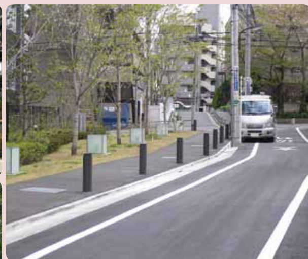
住宅街区北側道路・歩道状空地
