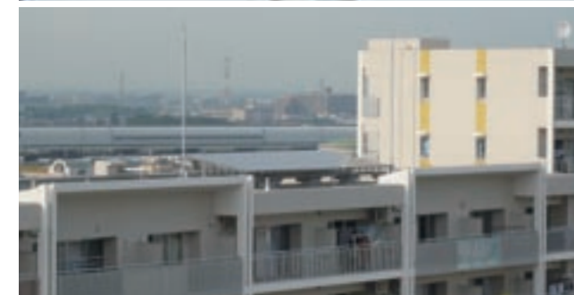
屋上に設置された約 5kw の太陽光発電設備 （コンフォール松原 / 埼玉県草加市）
