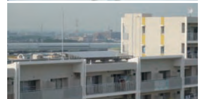
屋上に設置された約 5kw の太陽光発電設備（コンフォール松原 / 埼玉県草加市）
