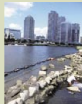
完成した海のビオトープ 「生態護岸」
