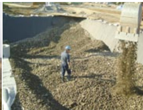
④現場にて路盤材や碎石雨水貯留槽などに再利用
