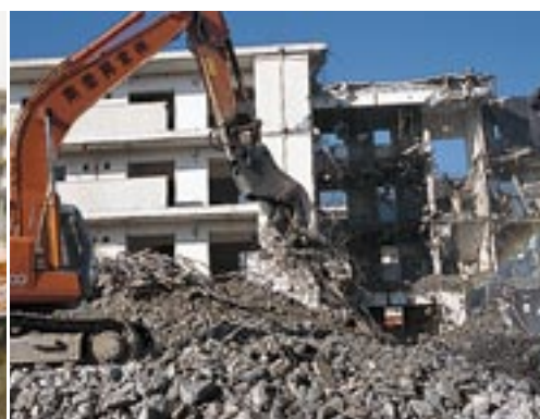
②混入した鉄筋などを分別しコンクリート塊を回収
