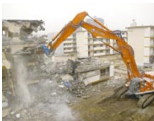
①既存建替対象建物の解体
