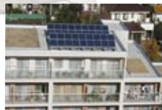
グリーンプラザひばりが丘南 （東京都西東京市）
