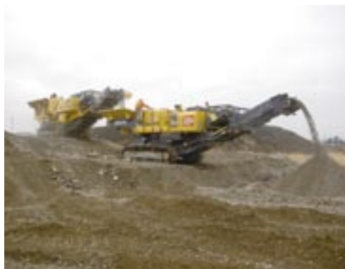
③コンクリート塊を細かく砕く
