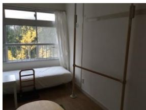
壁際に後付けの手すりを設置
