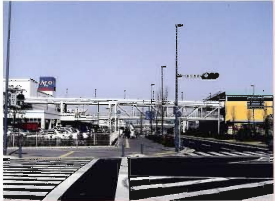
ARIO蘇我とホームセンターを結ぶ連絡橋
