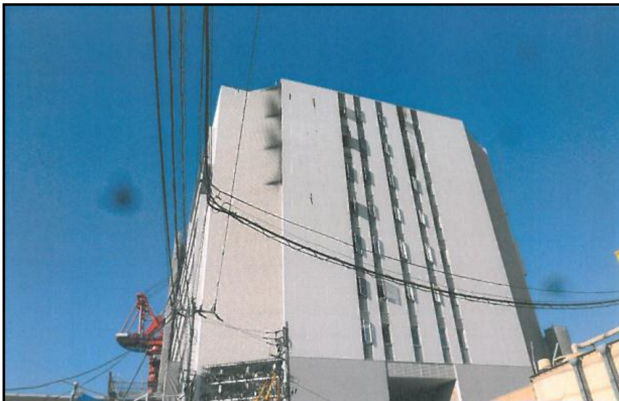
写真①：鎮火後の建物南側外部
