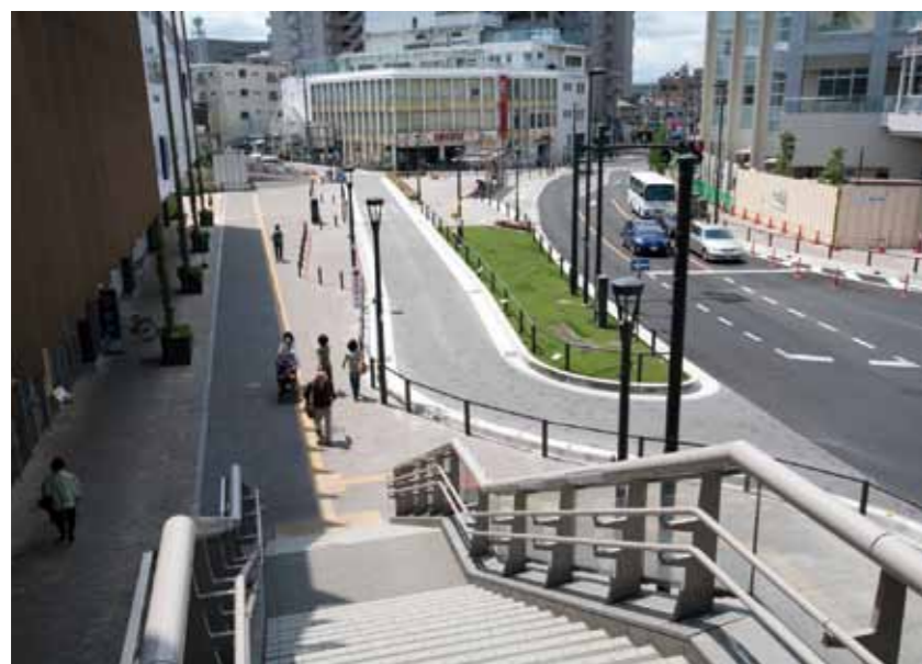
③新設した区画道路1号(緑地左側)と都市計画道路狭山市駅上諏訪線(緑地右側)。
