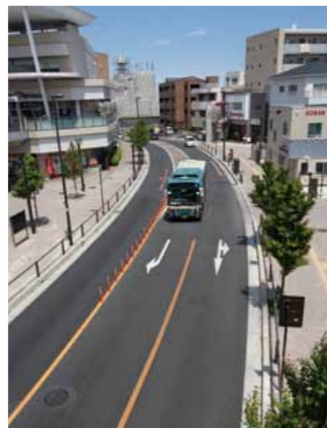
②新設した都市計画道路狭山市駅霞野線。
