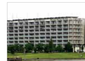
太陽熱パネルを設置した集合住宅 (越谷レイクタウン・環境共生モデル街区)
