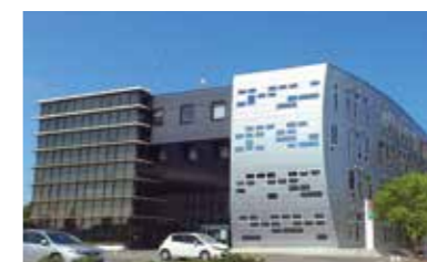
オフィスビル（いわきニュータウン）
