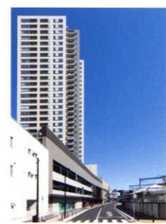
市道東寺尾第244号線側
