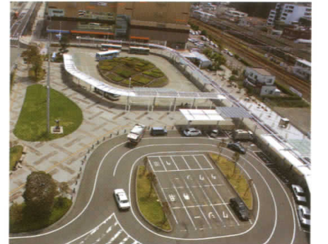
沼津駅北口駅前広場
