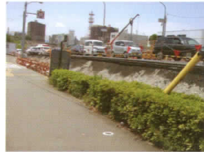
国道414号嵩上げ工事
