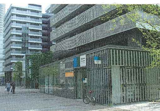
東雲キャナルコートCODANサービスセンター お住まいの方への管理窓口の他、住戸の内覧や予約申込を行っています。
