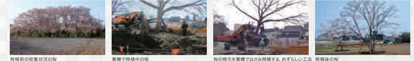
移植前の密集状況の桜 重機で移植中の桜 桜の根元を重機ではさみ移植する、めずらしい工法 移植後の桜
