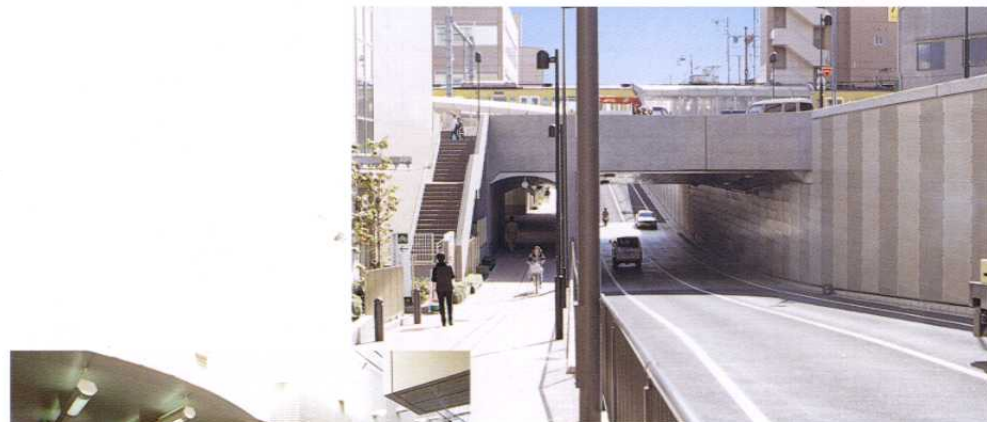
線路の下をアンダーパスする車道と広くて見通しのよい歩行者通路
