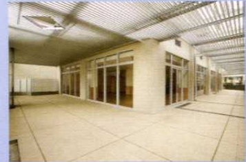
住宅棟2階回廊
