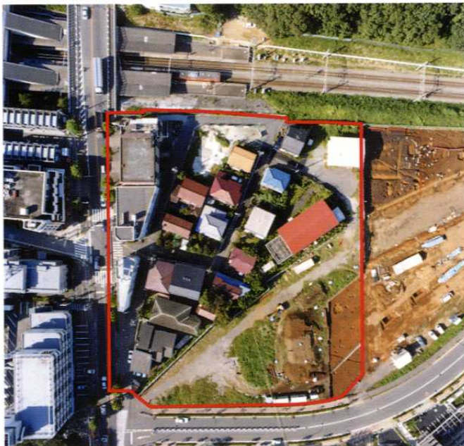
従前の地区（平成13年11月撮影）
