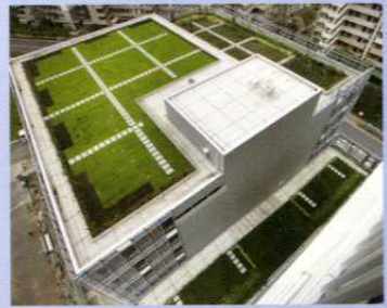
駐車場棟の屋上緑化
