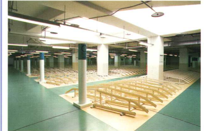
駅前広場地下自転車駐車場
