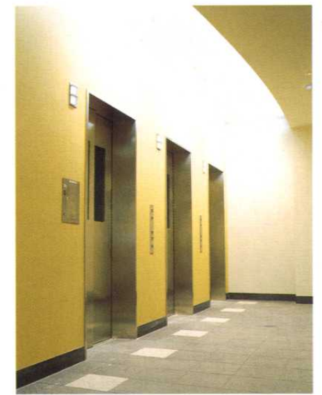
住宅棟エレベータホール
