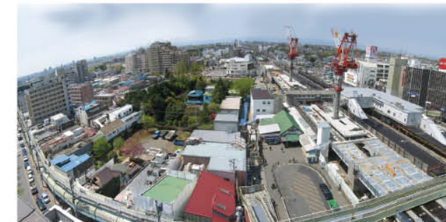
①除却前の地区現況(平成18年)
