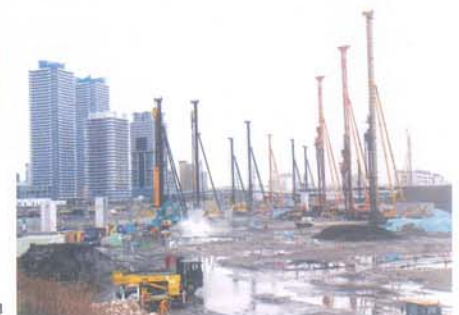
サンドドレーン工法による地盤改良
