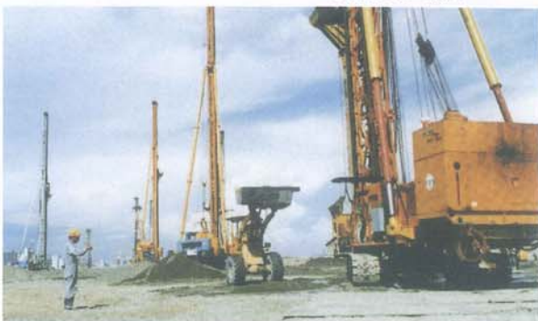
サンドドレーン工法による地盤改良工事
