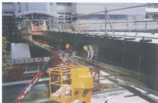
整備中のペDESTリアンデッキ
