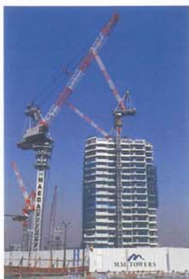
建設中のM.M.タワーズ
