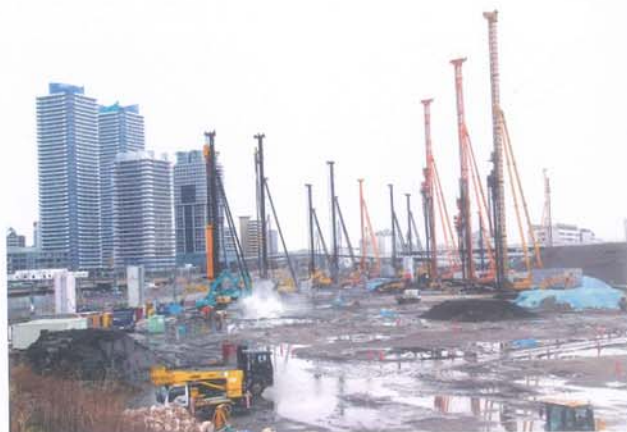
サンドドレーン工法による地盤改良
