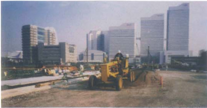
路盤工事中のみなとみらい5号線
