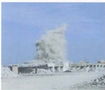
火薬発破による建物の解体
