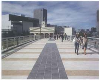
すずかけ通り歩道橋
