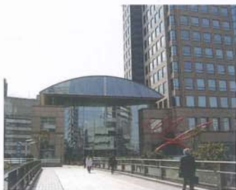
栄本町線歩道橋
