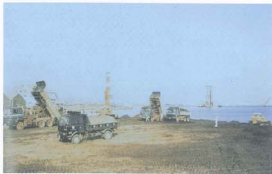
陸地側よりの埋立工事
