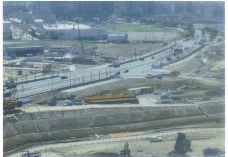
整備中のみなとみらい大通り(栄本町線)
