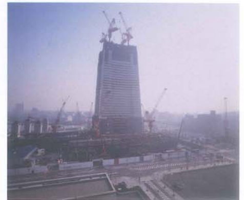
建設中の横浜ランドマークタワー
