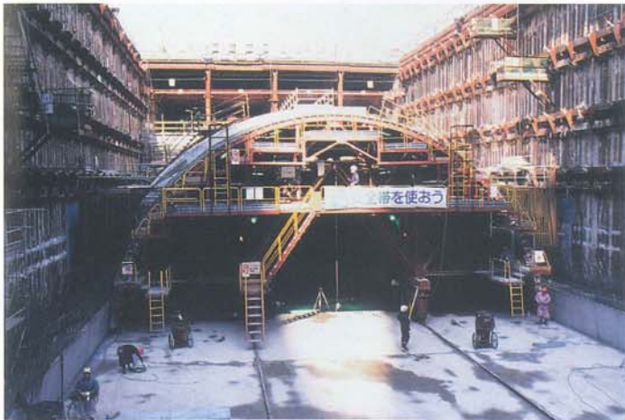
整備中のみなとみらい線
