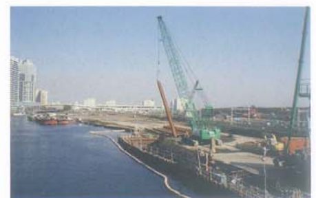
帷子川護岸工事の様子
