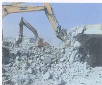
ジャイアントブレイカーによる造船所建物の撤去
