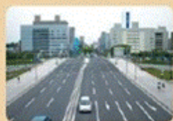
水戸南口停車場線と駅南大橋
