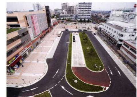
西口駅前広場：従前はバスの乗入れができなかった西口駅前に、タクシー・バスの乗降場を整備しました。
