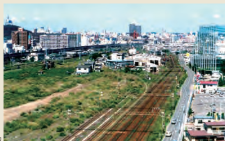
貨物ヤード跡地
