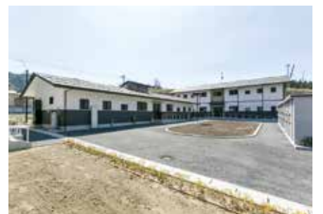
市営住宅 おおほら 大洞団地 (木造・1、2階・3棟・9戸・2DK)
