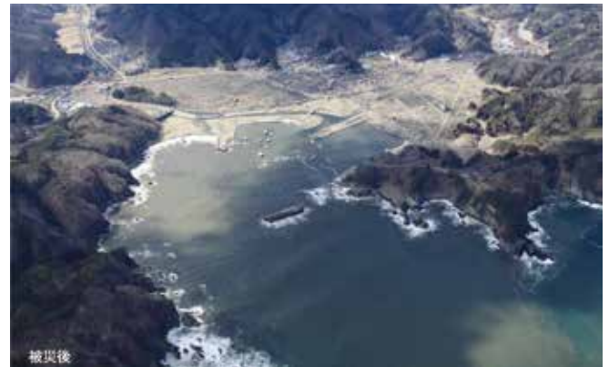
出典：いわて震災アーカイブ 提供者：岩手県県土整備部河川課/田老海岸 H23.3.28撮影
