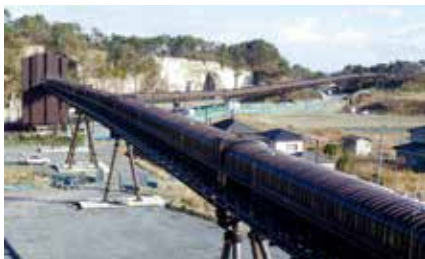
○ベルトコンベアによる土砂運搬(撤去済)
