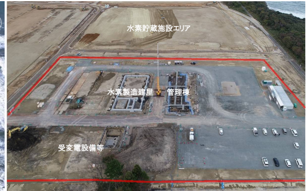
(水素プラント工事の状況)
