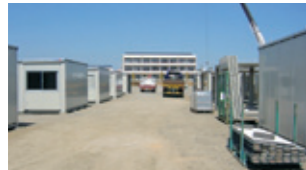
いわきニュータウンに建設された応急仮設住宅
