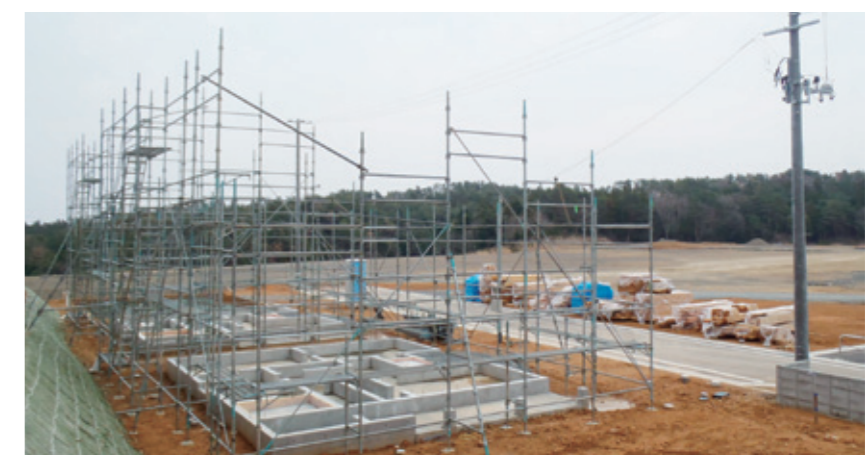
基礎工事の様子(出島地区)
