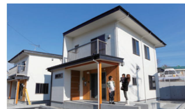
伊保石地区災害公営住宅(塩竈市)
