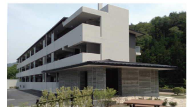
宇津野沢地区災害公営住宅(大船渡市)
