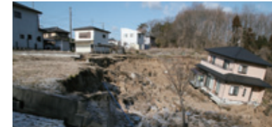
地滑りした住宅地
