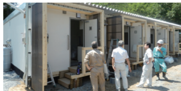
完成検査の様子
