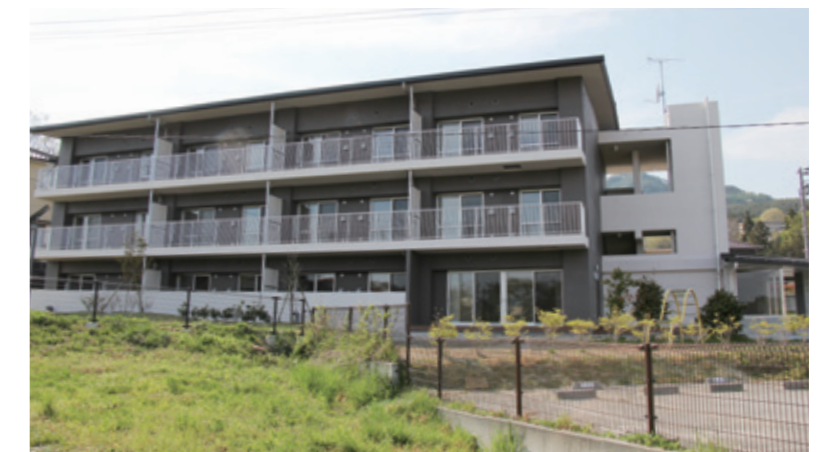
平林地区災害公営住宅
