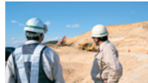
各地で大規模な工事が進む(東松島市)
