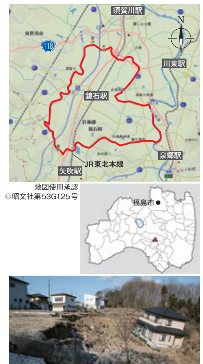
地滑りした住宅地
