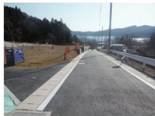
大石原浜地区 平成26年3月撮影
